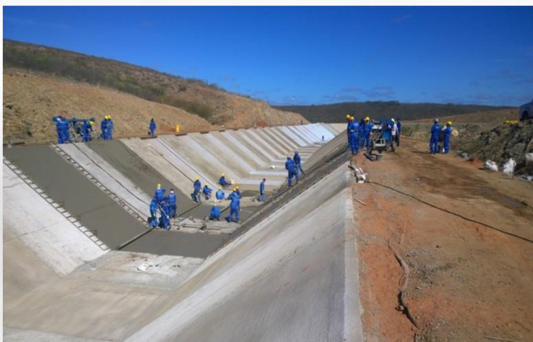
EXECUÇÃO DO CONCRETO DE PROTEÇÃO DA MANTA KM 1+400
