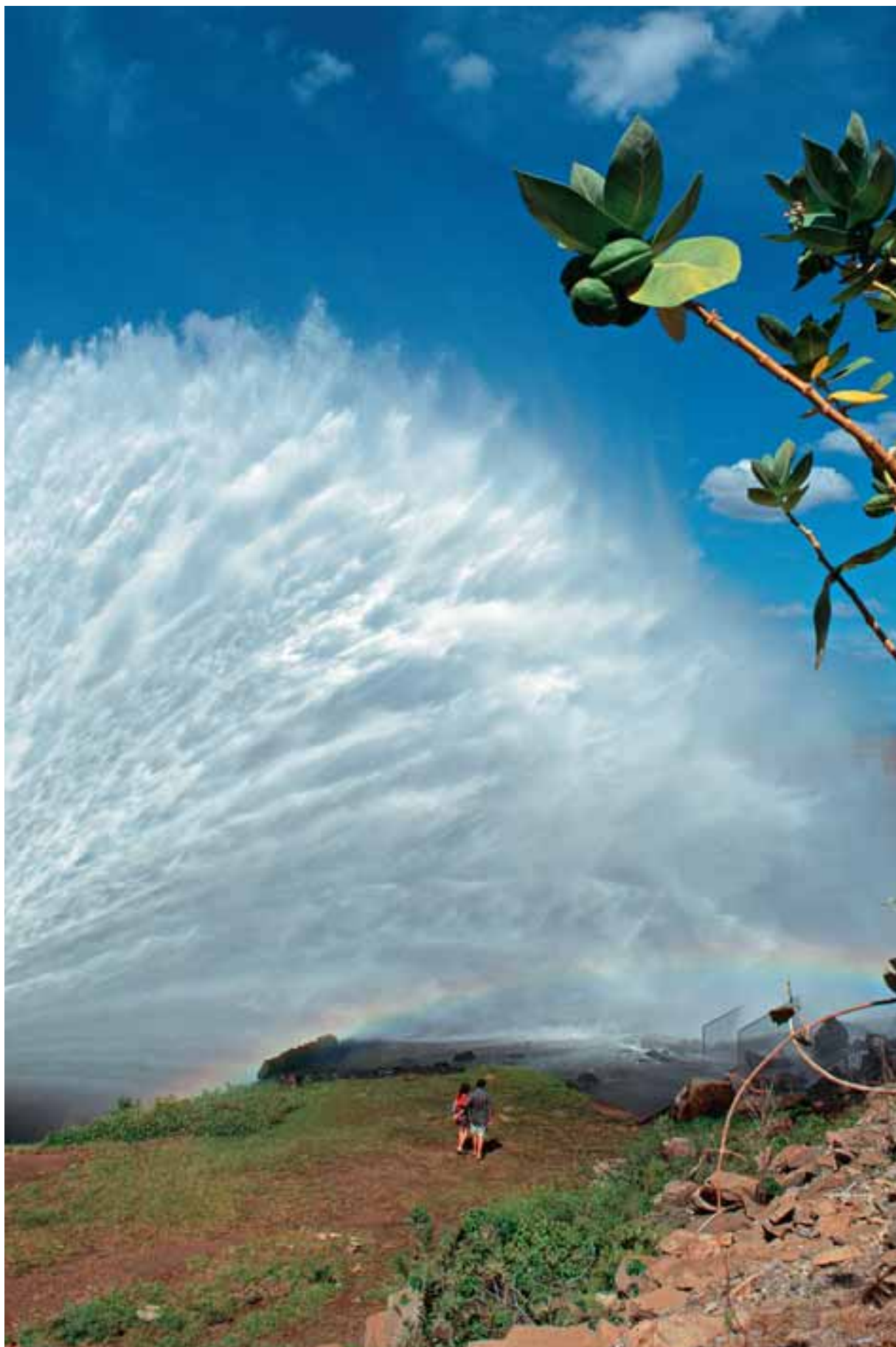
Açude Orós com válvulas abertas
