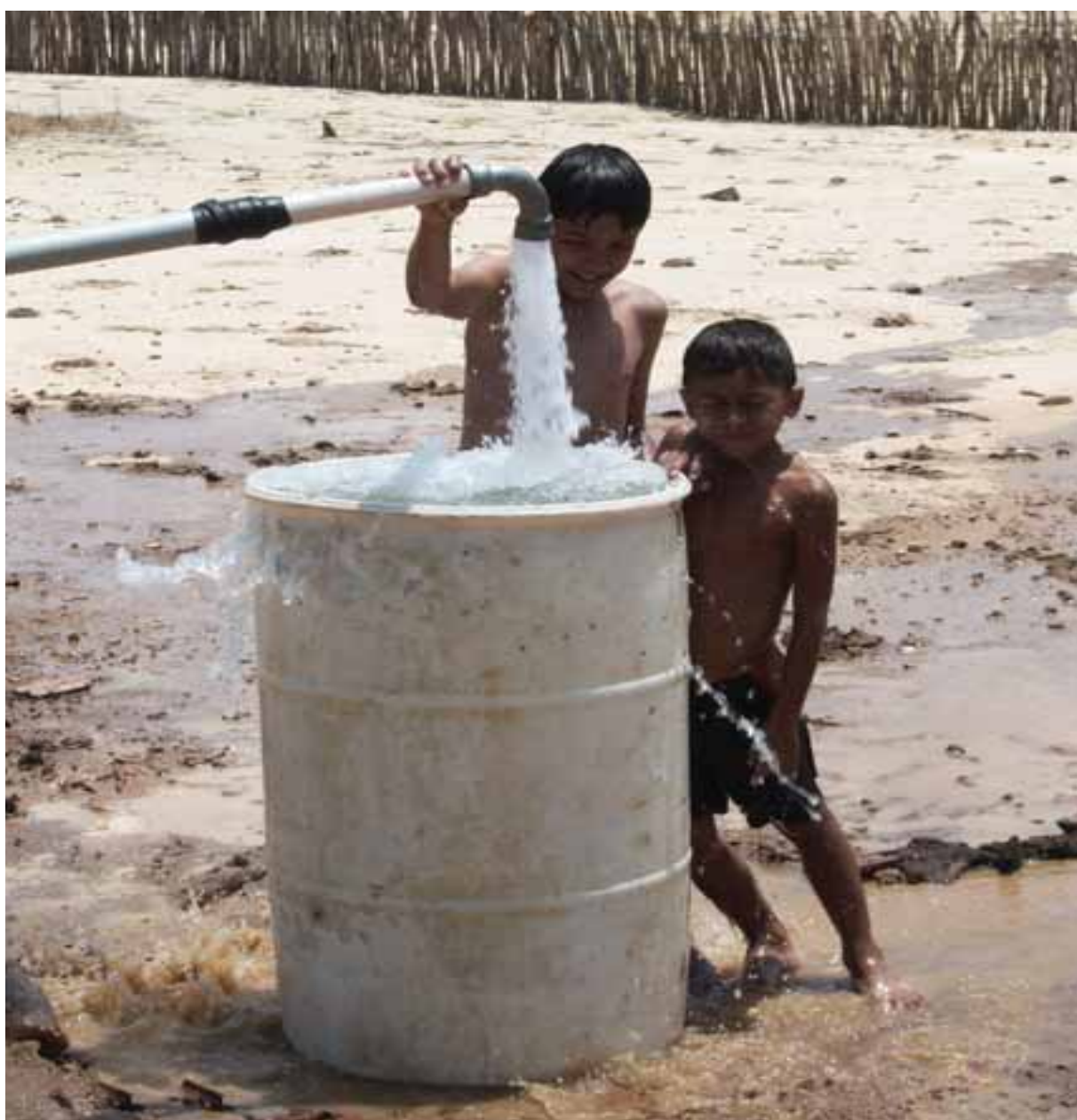
Aiuaba / Teste de bombeamento de poço.
