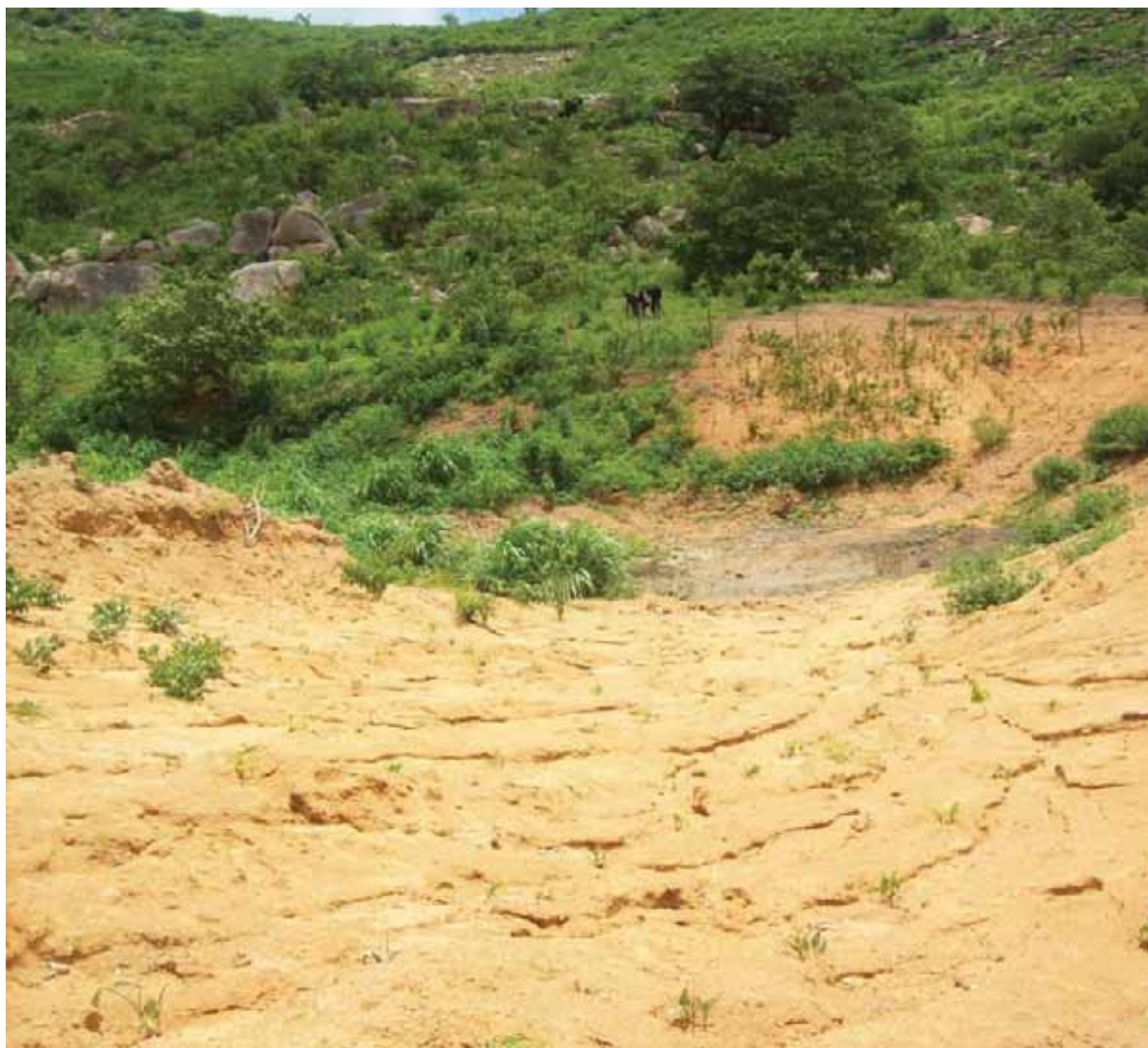
Erosão e assoreamento dos corpos hídricos na bacia
