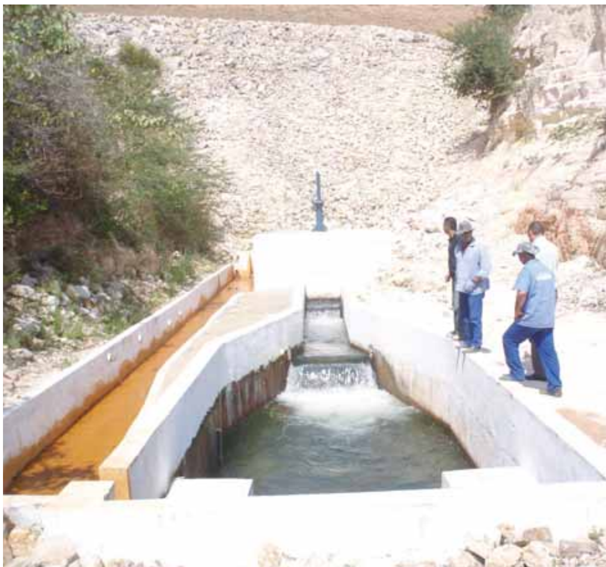
Tianguá / Drenagem próxima à parede do Açude Jaburu
