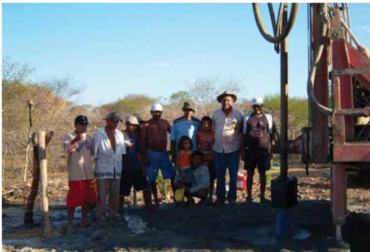
Crateús / Moradores da região acompanham perfuração de poço
