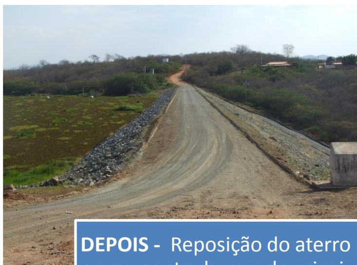
**DEPOIS** - Reposição do aterro no coroamento da parede principal.
