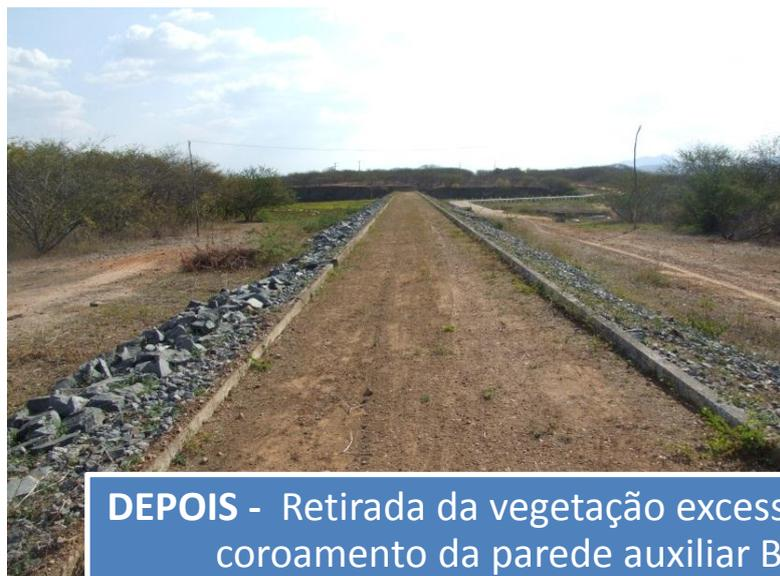
**DEPOIS** - Retirada da vegetação excessiva no coroamento da parede auxiliar B (Sangradouro).
