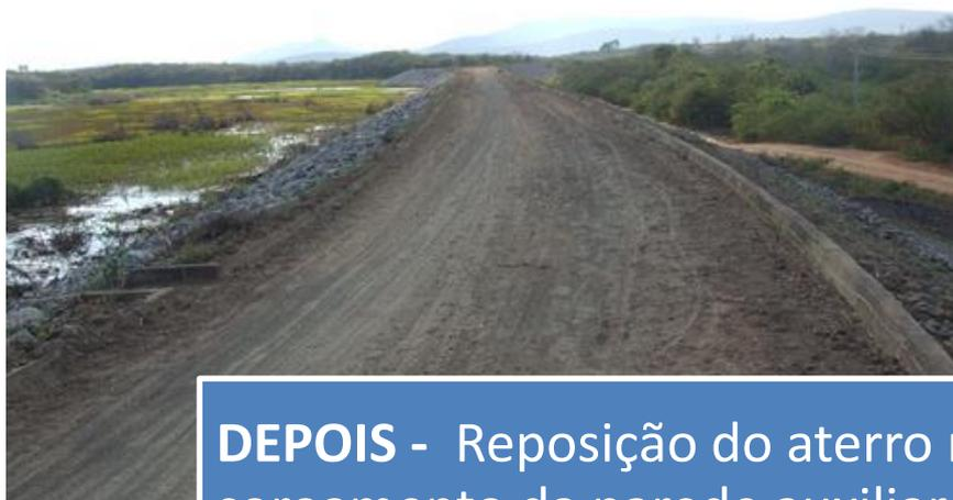
**DEPOIS** - Reposição do aterro no coroamento da parede auxiliar D.
