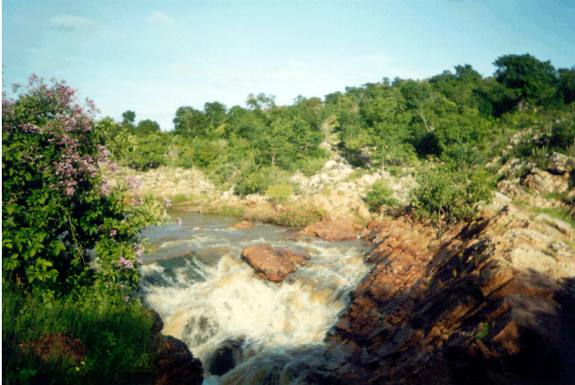
FOTO 01: Açude Paula Pessoa: vista da ombreira direita do barramento. Observa-se, em primeiro plano, o leito rochosos do rio Itacolomi (Coordenadas 291.352mE e 9.628.133mN).
