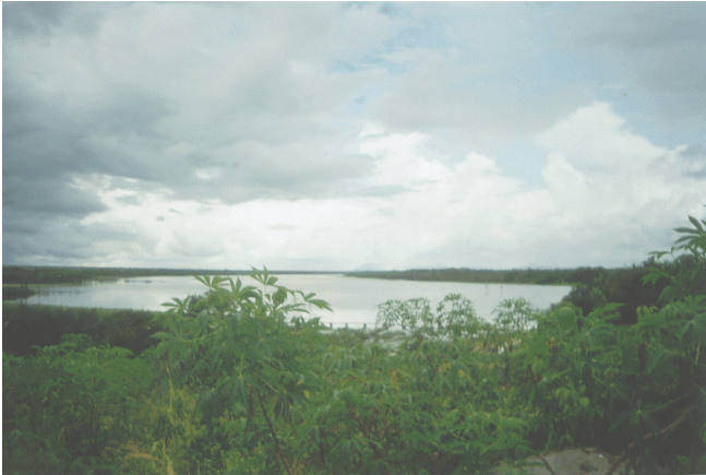
FOTO 01: Açude Cajueirinho: vista parcial do Açude Cajueiro, o qual será englobado pela bacia hidráulica do açude ora proposto, que se constitui num alargamento do reservatório já existente (Coordenadas 335.900mE e 9.659.651mN).
