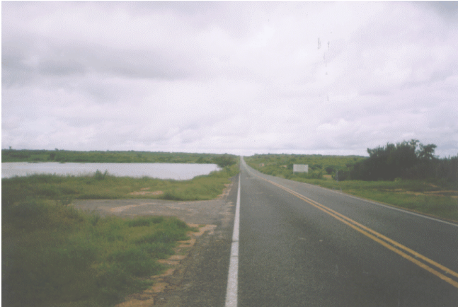
FOTO 01: Açude Fronteiras: vista parcial do trecho da BR-404, que será submerso. Observa-se na lateral da rodovia, o açude Lindeza.
