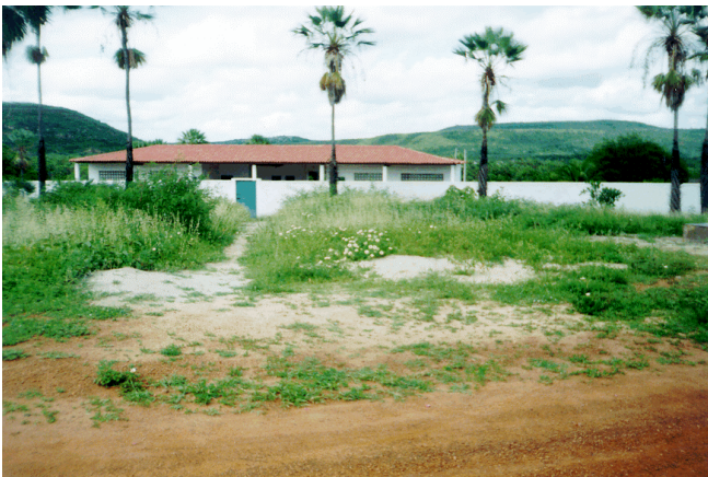
FOTO 03: Açude Inhuçu: grupo escolar da localidade de Melancias, recentemente construído, o qual será submerso.
