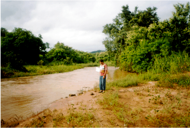
FOTO 01: Açude Frecheirinha: vista parcial do riacho Jatobá no local do eixo do barramento (coordenadas 302.052mE e 9.582.096mN).
