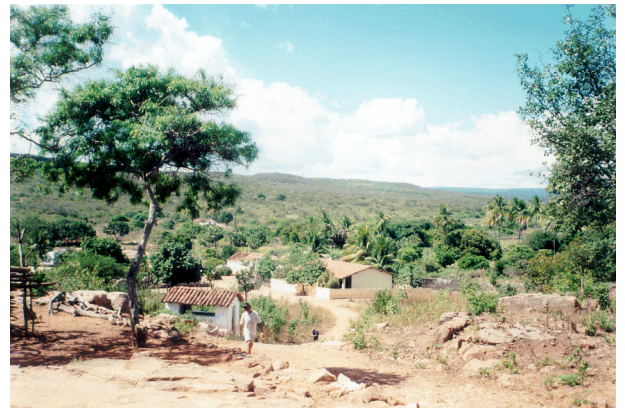
FOTO 04: Açude Lontras: vista parcial da localidade de Barra do Lino (parte baixa), a qual encontra-se posicionada dentro da bacia hidráulica do reservatório.
