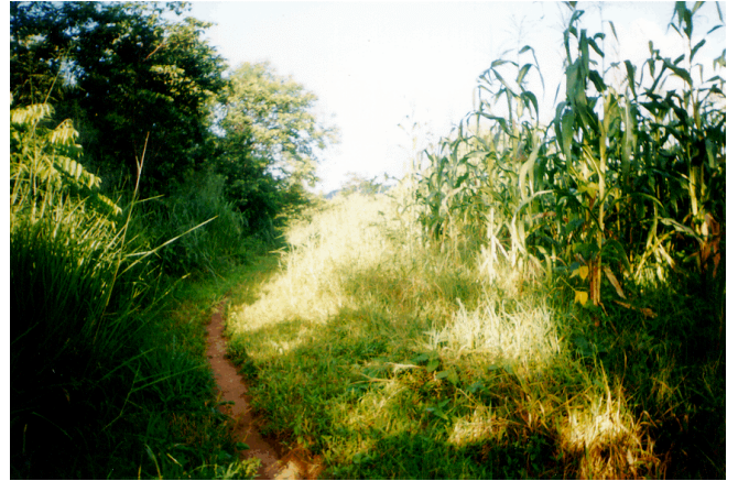
FOTO 02: Açude Frecheirinha: ombreira direita do barramento.
