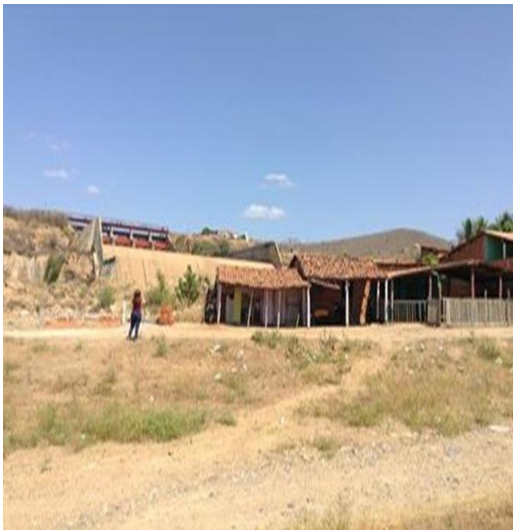
Figura 3.12 – Barragem Banabuiú - Foto Ocupação a jusante e Vertedor
