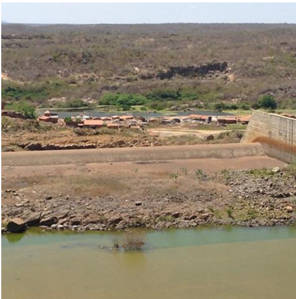
Figura 3.11 – Foto Barragem Banabuiú - Vertedor e ocupação a jusante
