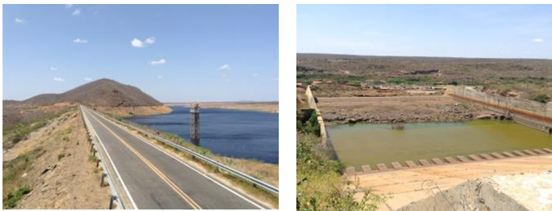
Figura 3.8 - Fotos Barragem e Vertedor Banabuiú
