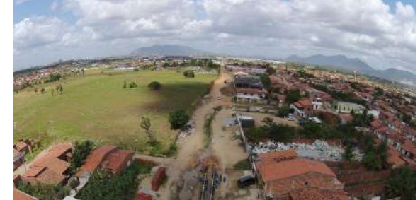
Obra do Programa DRENURB
