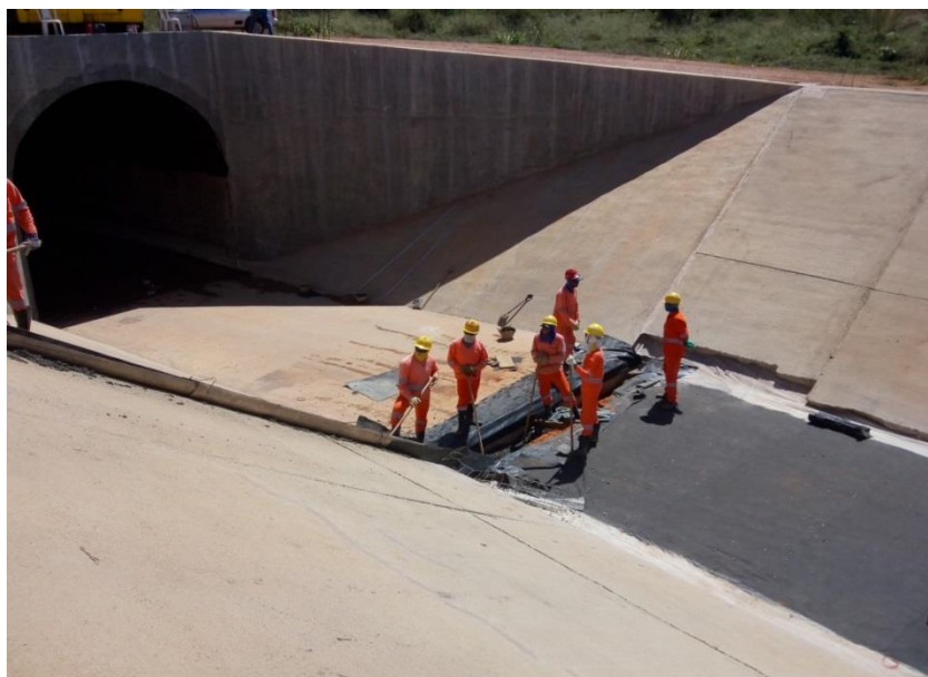
Vista de Emboque no Túnel Boa Vista
