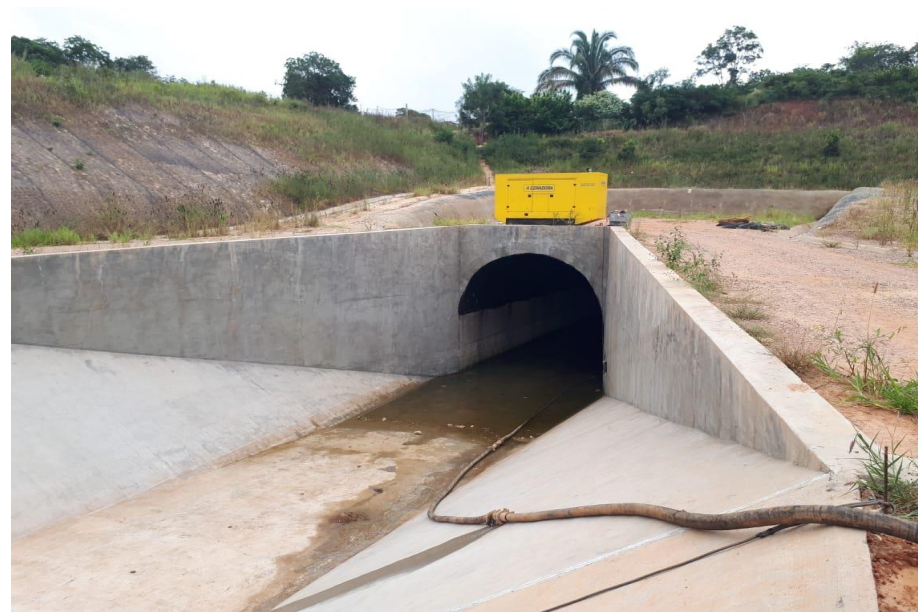
Vista de Emboque do Túnel Arajara
