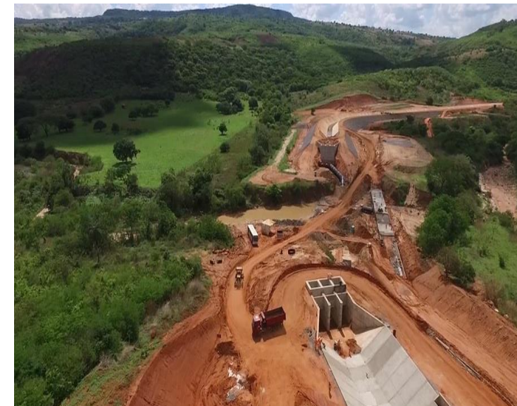
Sifão Riacho Seco - Trecho emergencial
