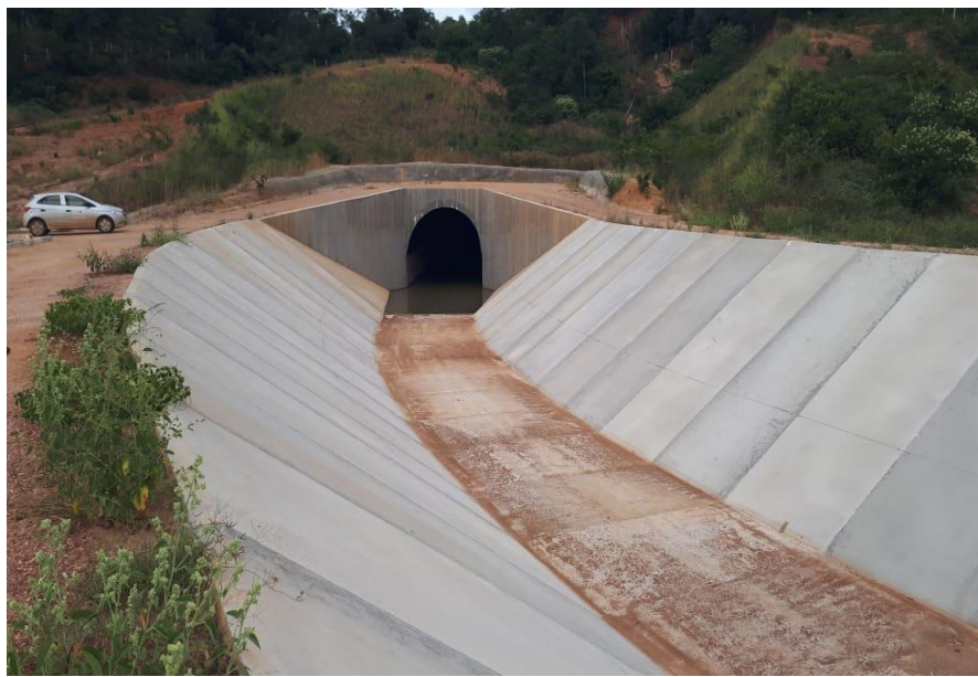
Vista do desemboque do Túnel Cabeceiras
