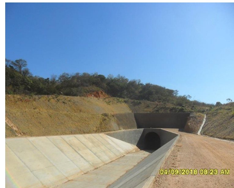
Túnel Sitio Alto 1
