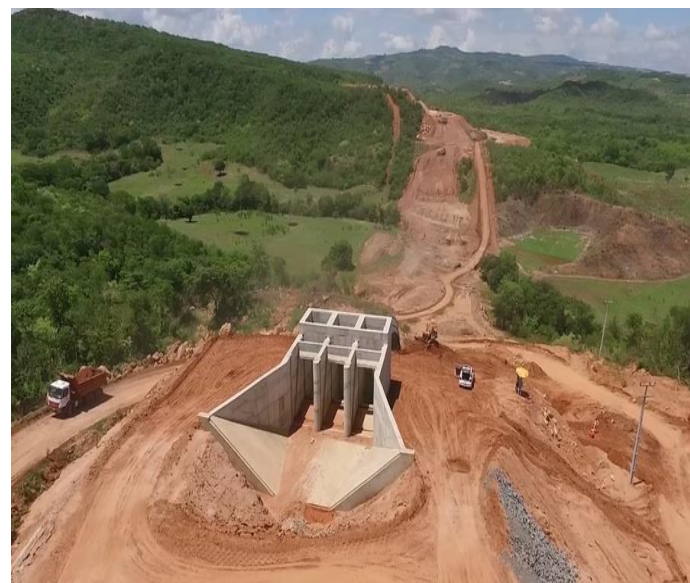
Sifão Boqueirão - Trecho emergencial
